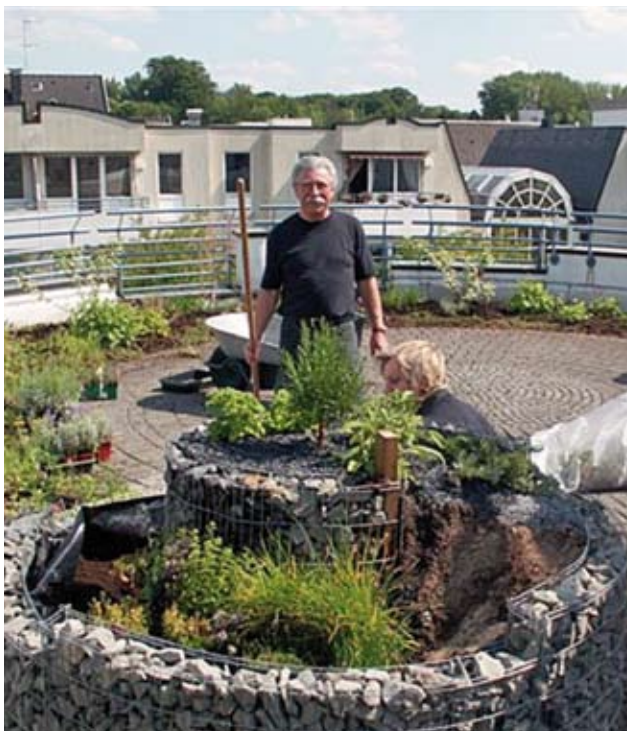
Ehrenamtliche Helfer gestalten die Dachterrasse
